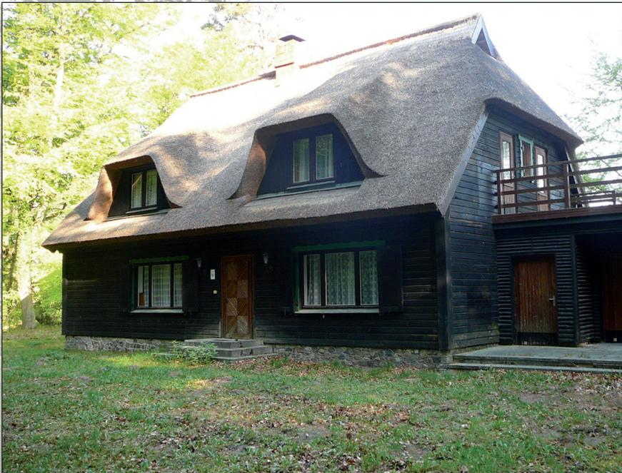
**Saniert:** Mit dem neuen Reetdach wird das Objekt wieder zum Schmuckstück, für viele Jahre.
